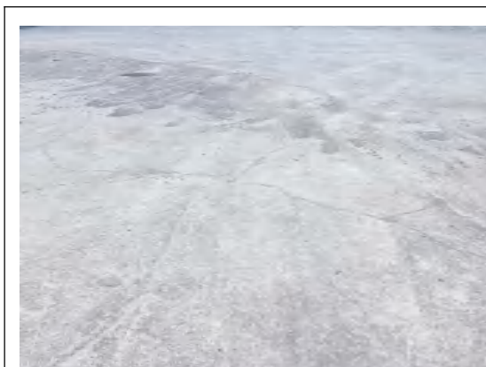
厂区地面硬化
